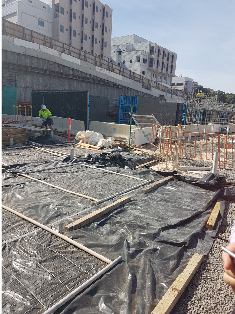
Preparations for the first basement slab concrete pour
